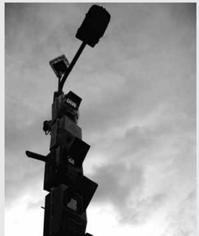
Figura 4. Semáforo ambiental instalado en la Universidad de los Andes.
