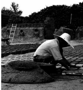
Figura 18. Proceso obra de construcción de la obra de título: Horno de ladrillo artesanal invertido de Diego Parra. Curicó, 2011. Fotografía: Diego Parra.
