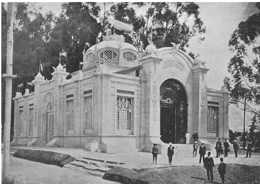
Imagen n° 1: Pabellón de Bellas Artes (vista exterior)
