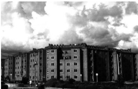
Figura 1. Vista parcial de los 1 250 calentadores solares instalados por el Centro Las Gaviotas a mediados de los ochenta en Ciudad Salitre, Bogotá, urbanización del Banco Central Hipotecario.
